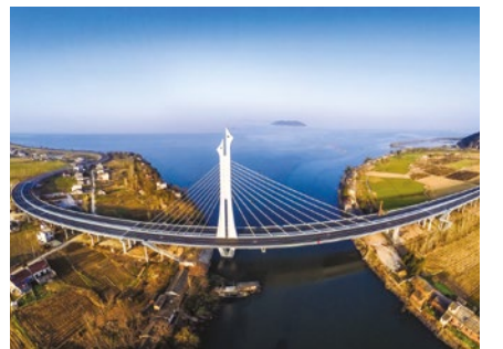
中國鐵建獨塔單索面斜拉橋——安徽環巢湖旅遊大道白石天河大橋，全長826米，主橋寬27.5米，塔高88米，主塔採用雙白鷺造型混凝土橋塔。
