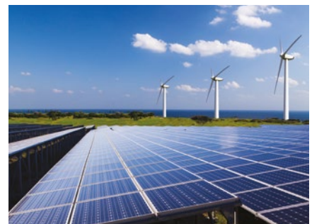
再生能源設施
